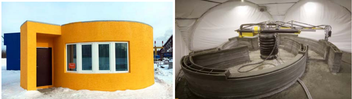
Figure 8 (a) Vue de face de la maison Apis Cor en Russie ; (b) Processus de fabrication de la maison Apis Cor. [31]
